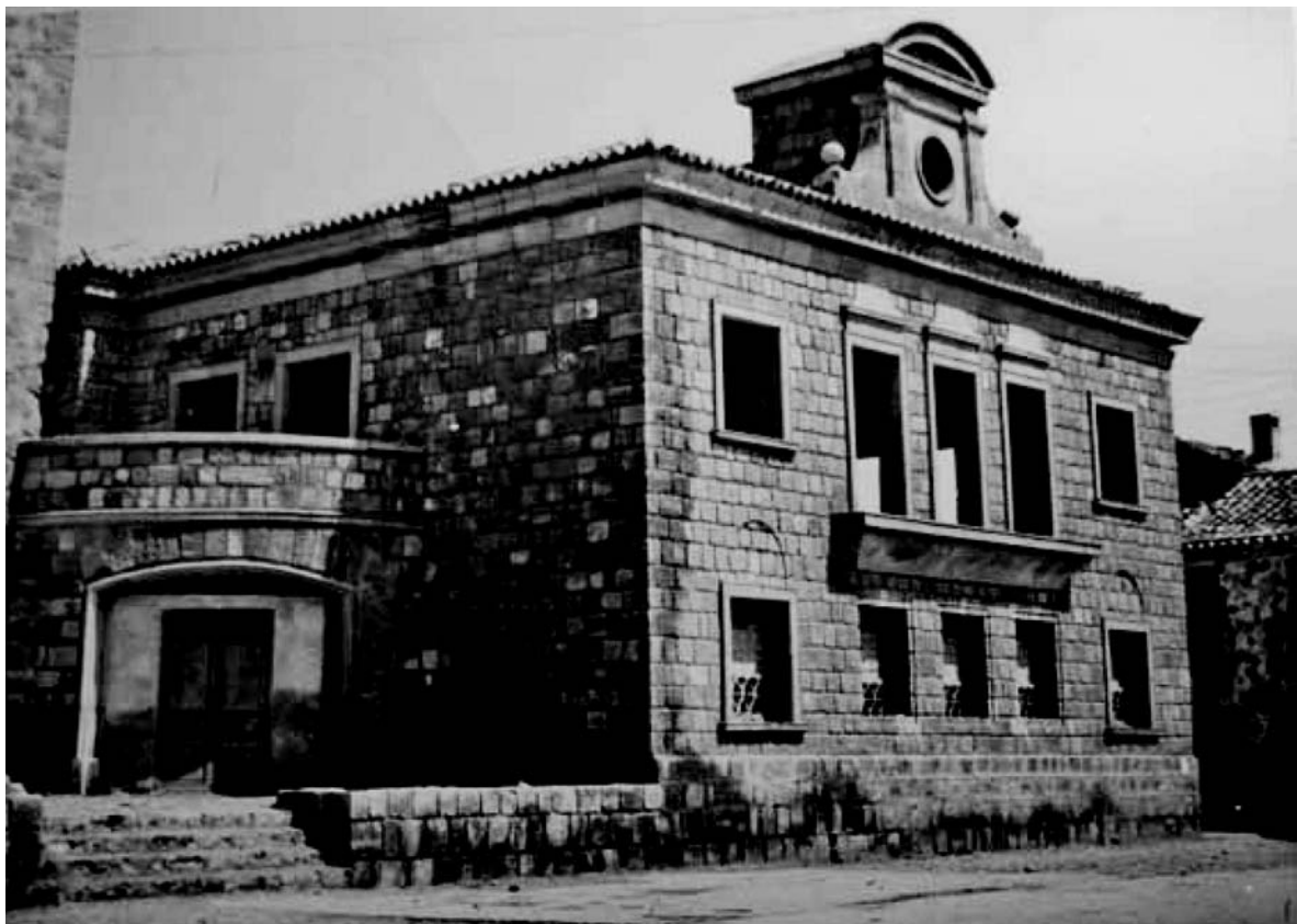
El Ayuntamiento, en una de las fases de su construcción.
